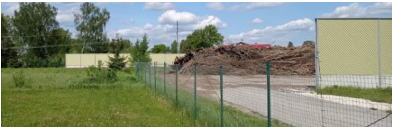
Joonis 3. Müratõkkeseinad Jaama 8 käitlusplatsil, mai 2025.
